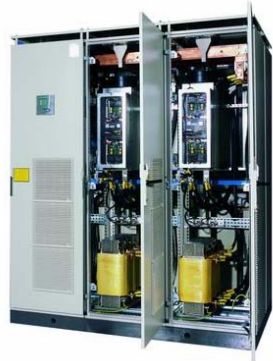
Автоматическая конденсаторная установка с тиристорным переключением
